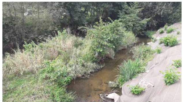
Vue depuis l'amont
