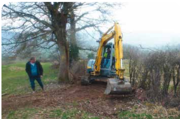
Intervention du tracto-pelle
