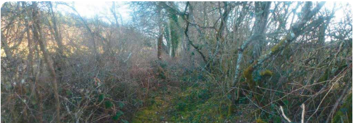
Chemin avant travaux
