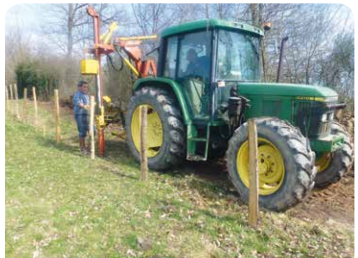
Installation des piquets + clôture avec les agriculteurs
