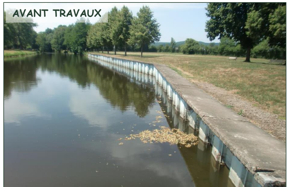
Enlèvement des palplanches, retalutage des berges et mise en place de blocs dans le lit pour diversifier les écoulements Été 2022
