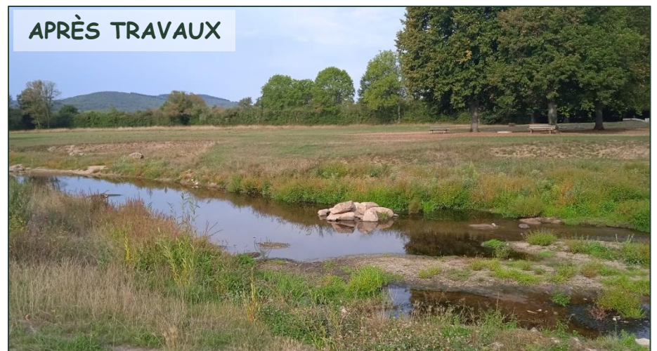
Enlèvement des palplanches, retalutage des berges et mise en place de blocs dans le lit pour diversifier les écoulements Été 2022
